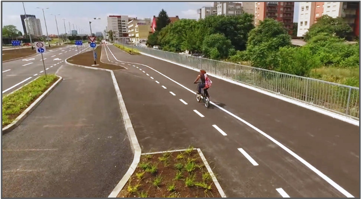
Staza uz Novu Branimirovu izgrađena prema Pravilniku o biciklističkoj infrastrukturi
